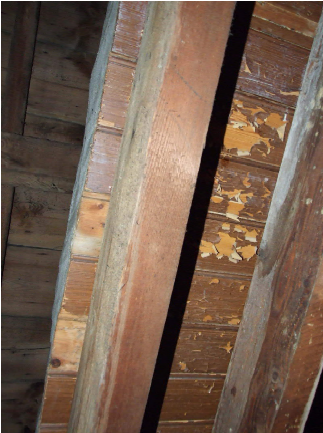
(31) ondersteuning rookkanaal in de kap met hergebruikt hout (gladhout schilderwerk)
