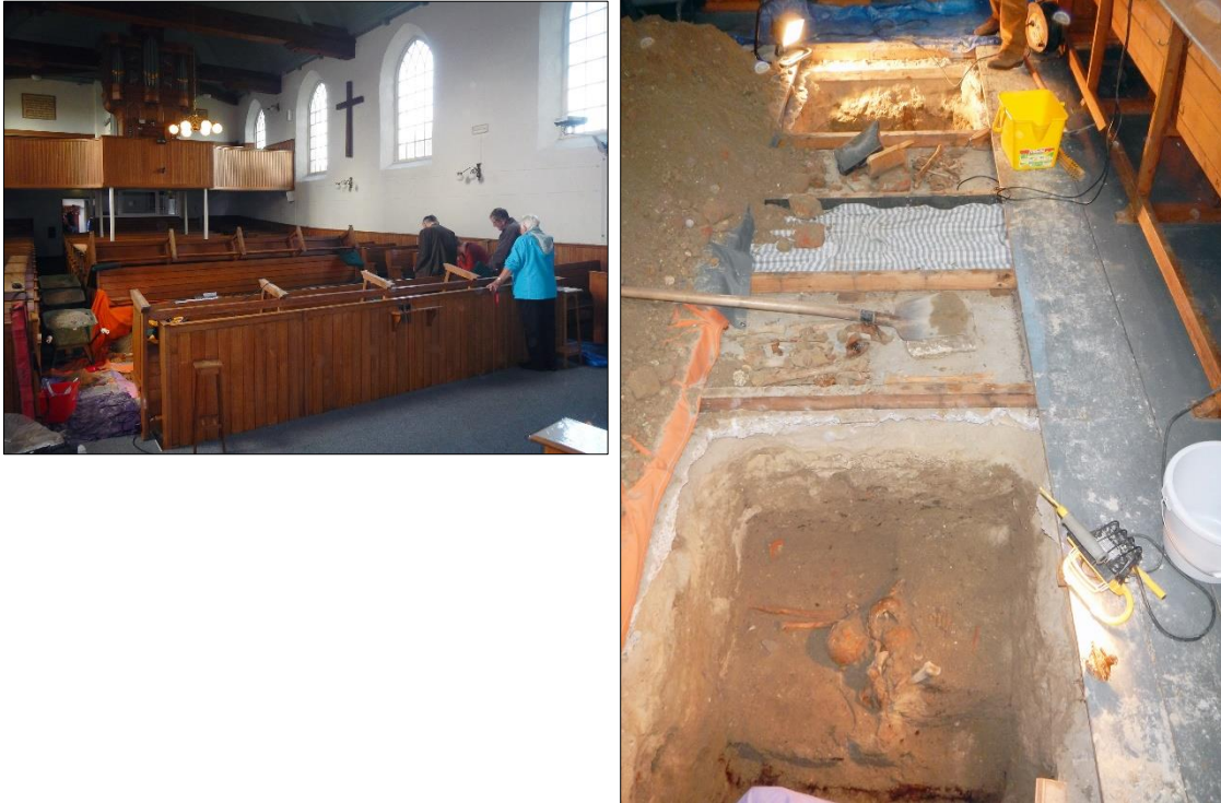
Afbeelding 8 Het archeologisch onderzoek in de Michaëlskerk. Links: de werkputten bevinden zich achter de eerste rij koorstoelen. Het onderzoek kon op belangstelling rekenen van verschillende leden van de kerk. Rechts: Zicht op de uitgegraven putten in de kerk. Op de voorgrond is werkput 1 te zien. Onder in de put bevindt zich een concentratie aan menselijk bot.
