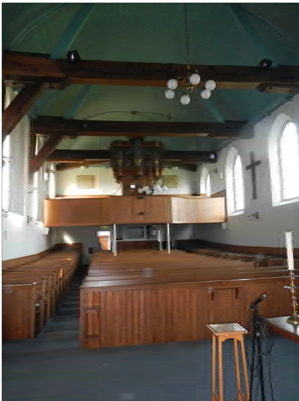
Afbeelding 25 Zicht vanaf het oostelijk deel van de zaal naar het westen. Dit deel, rond de preekstoel is verhoogd met een houten vloer. Achterin de zaal, onder de galerij, loopt het vloerniveau circa 30 cm op. Foto: Artefact!
