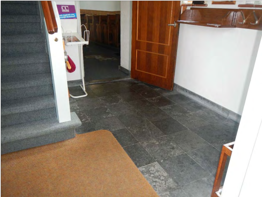
Afbeelding 26 De vloer van het in 1952 gebouwde entreepoortaal aan de westzijde van het kerkgebouw (hoofdingang). Deze vloer loopt op gelijke hoogte met de oplopende vloerniveau aan de westzijde van de zaal onder de galerij. Foto: Artefact!.
