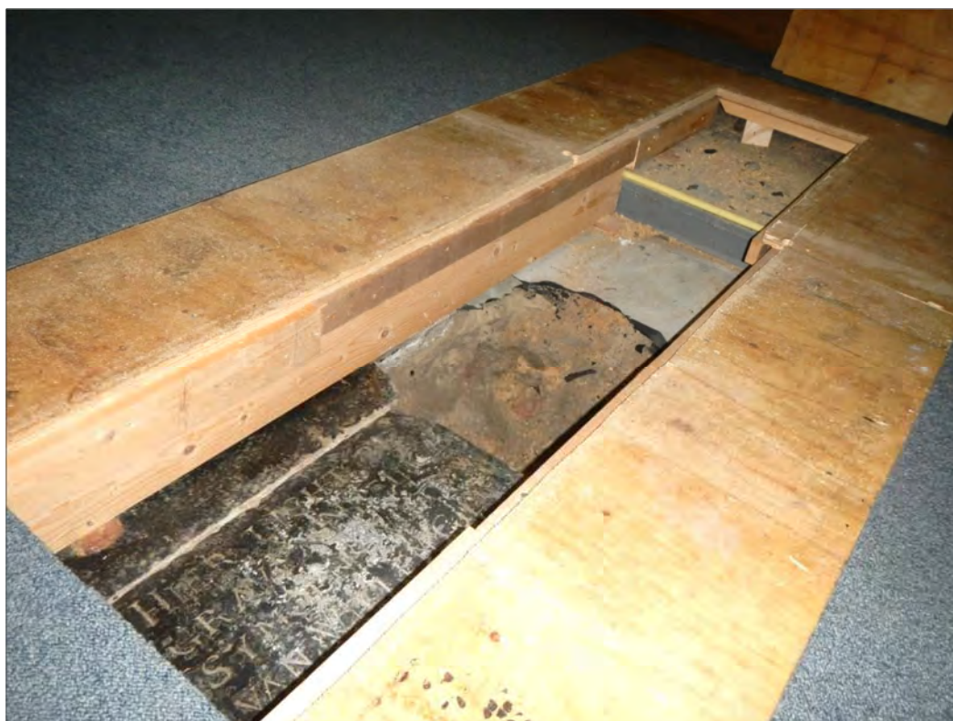
Afbeelding 23 Het kijkgat onder de vloer ter plaatse van de voormalige dooptuin aan de oostzijde van de grote zaal. Onder de 17 de -eeuwse grafsteen is minstens 40 cm zand met daarin wat puin aanwezig, aangebracht tijdens de renovatie van 1952. Foto: Artefact!
